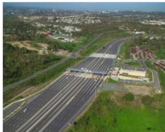
Vista aérea de Fase I de autopista PR-66 entre los municipios de Carolina y Canóvanas.
